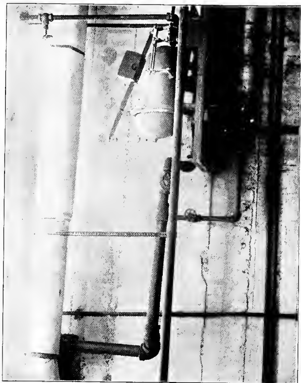
FIG. 70. — Tilt Trap.
