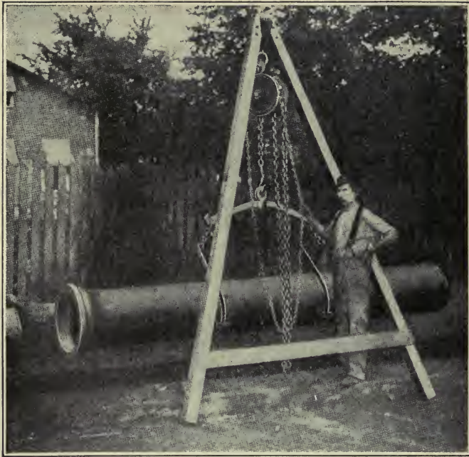
FIG. 279. — Pipe Derrick.
