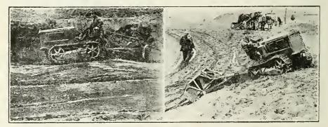
A MOTORIZED FRESNO SCRAPER IN OPERATION.
