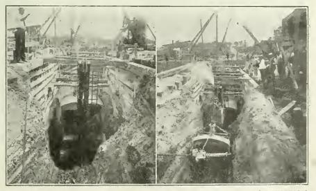
STEAM SHOVEL AND DRAGLINE OPERATE EFFICIENTLY IN CONJUNCTION ON HEAVY SEWER EXCAVATION IN DETROIT.
