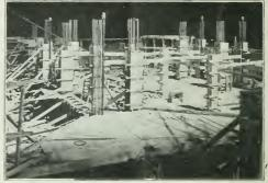
LIGHTING NIGHT CONSTRUCTION FROM TOP OF CON-CRETE HOISTING TOWER.
