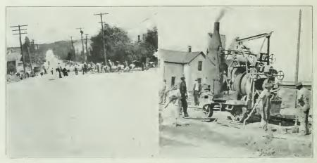
STREET PAVING VIEWS IN KALAMAZOO, MICH. LEFT—LAYING HILLSIDE BRICK ON WEST STREET. RIGHT—CHAIN BELT MIXER LAYING CONCRETE FOUNDATION ON SAME STREET.
