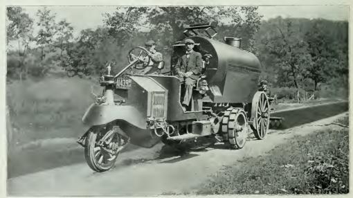
TRAILER "OIL DISTRIBUTER" OF TYPE ESPECIALLY EFFICIENT ON LONG HAUL JOBS.
