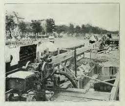
USING ATLANTIC PUMPING ENGINES ON CONEY ISLAND TERMINAL EXCAVATION.
