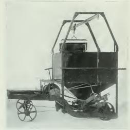
LOCOMOTIVE HOPPER FOR CHARGING CONCRETE MIXER.
