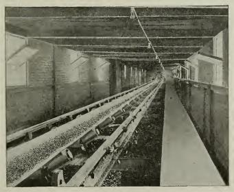
III. BELT CONVEYORS DISCHARGING COAL IN THE STORAGE
