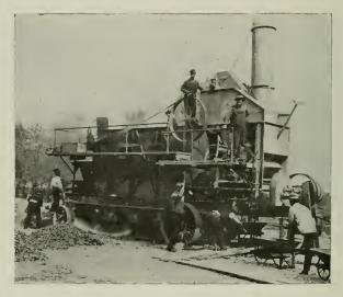
LINK-BELT CO.'S PORTABLE ASPHALT PLANT.
