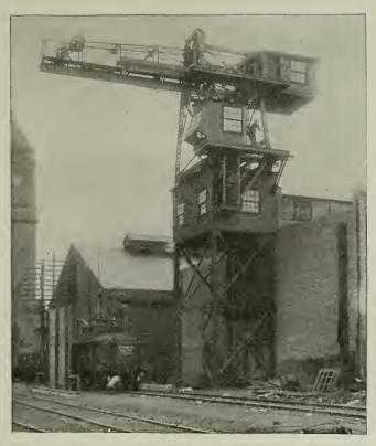
II. HOISTING TOWER WITH GRAB BUCKET AND HOPPER AT THE POWER HOUSE OF THE PEORIA GAS AND ELECTRICAL CO., PEORIA, ILL.
