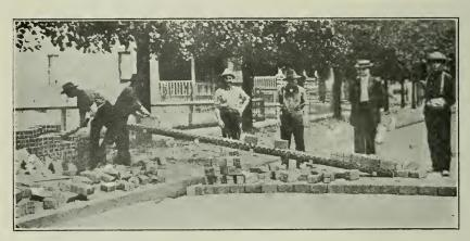
MATHEWS GRAVITY PAVING BRICK CARRIER IN OPERATION.
