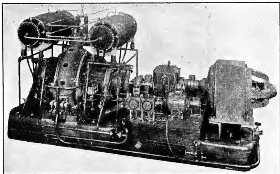
FIG. 221.—200 kw. Alexanderson alternator.
