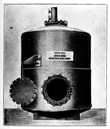
Fig. 21.—Sinclair's "Vomiting" Esparto Boiler.
