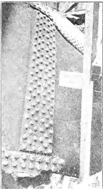
FIG. 5. CRACKED BUTT-STRAP.
