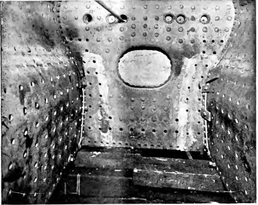
FIG. 2. WELDED FIRE-BOX.
