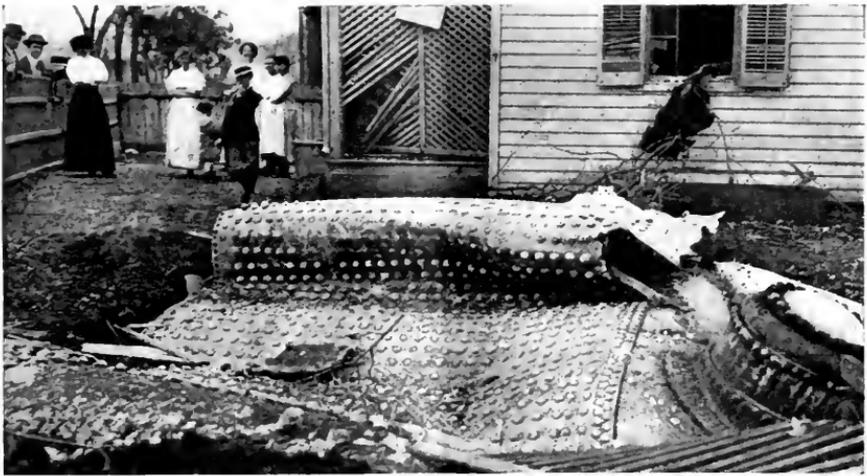
FIG. 2. WRAPPER SHEET AND DOME IN DOOR YARD.
