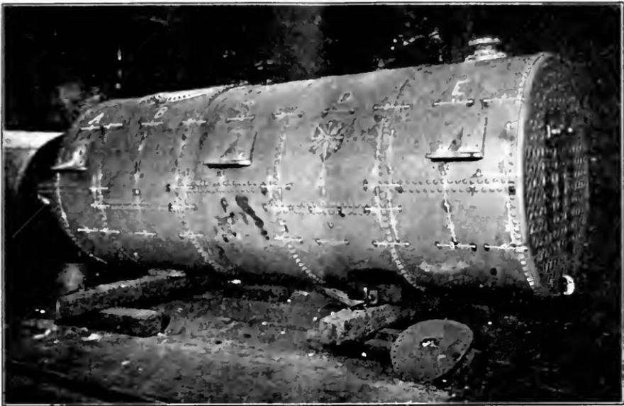
FIG. 4. BOILER 4092 PRIOR TO THE TEST. NOTE THE 10-INCH GAGED LENGTHS.
