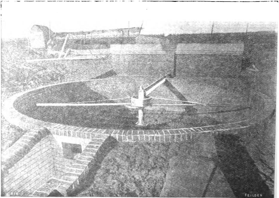
FIG. 49. CANDY-CAINK SPRINKLER BEFORE THE BED IS FILLED.
