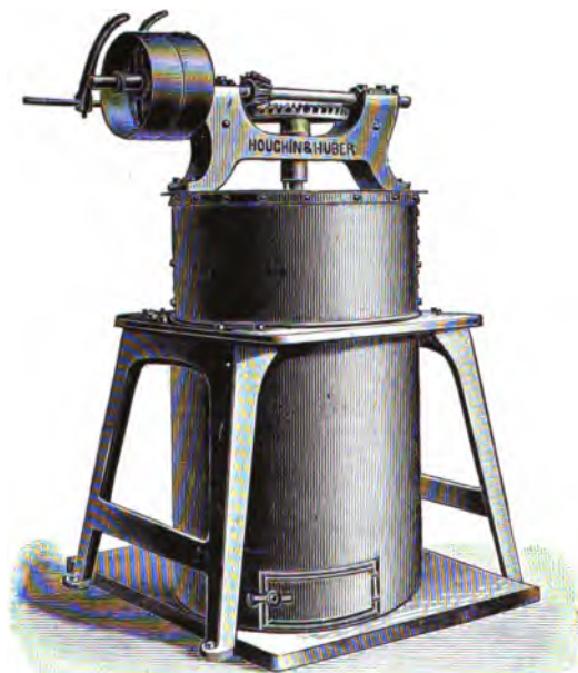
FIG. 41.—Caustic-soda Grinder.
