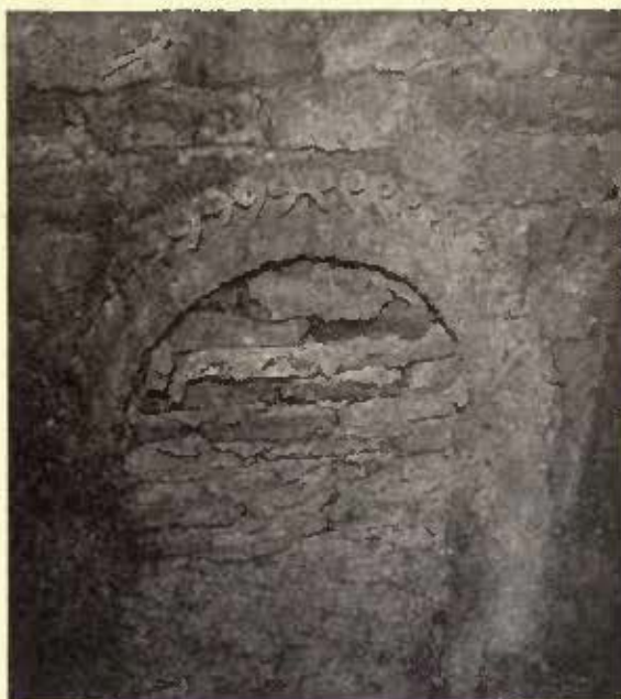
Fig. 217.—Zara. San Donato. External door of staircase (about 801-806).
