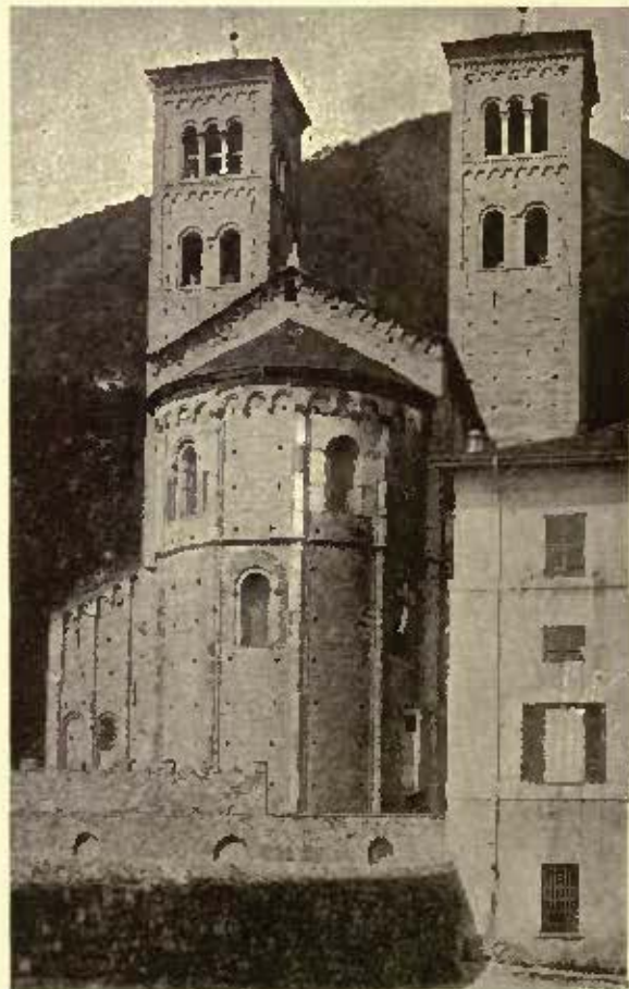
Fig. 294.—Como. Sant' Abondio (1013-1095).
