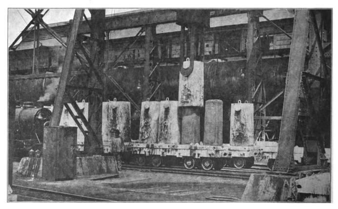
AUTOMATIC STRIPPER TAKING THE MOLDS OFF RED HOT INGOTS
