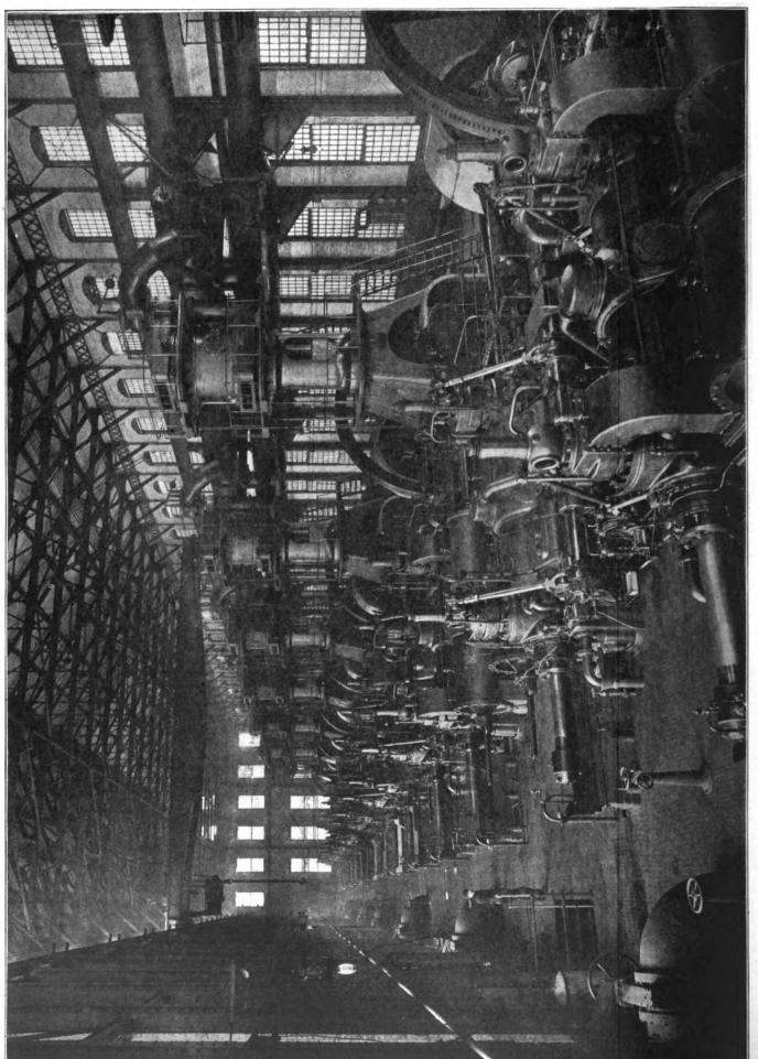
THE BIG GAS ENGINES AT THE LACKAWANNA STEEL PLANT ARE OPERATED BY THE WASTE FURNACE GAS. THEY RUN THE BLOWERS WHICH SUPPLY THE BLAST
