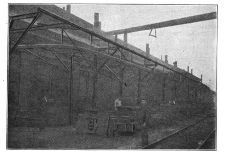
FIG. 5. DIE PLATFORM AND THE OVERHEAD TROLLEY FOR HANDLING HEAVY DIES
