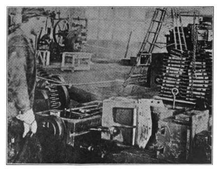
FIG. 10. THE BULLDOZER BENDS THE PLATES INTO A U-SHAPE
