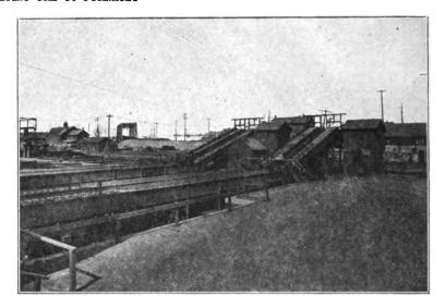
FROM LADLE TO CARS. ENDLESS CHAIN-MOLDS FOR PIG IRON
