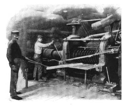
FIG. 5-ROLLING TUBES HOT AFTER THE PIERCING OPERATION
