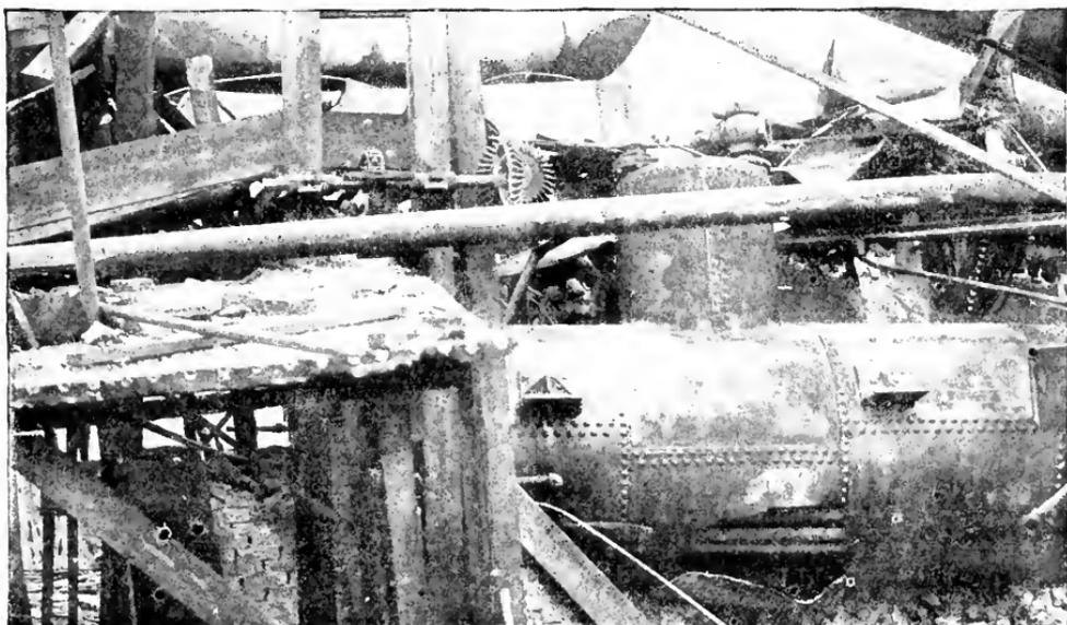
FIG. 1. -- SHOWING THE EXPLODED BOILER.
