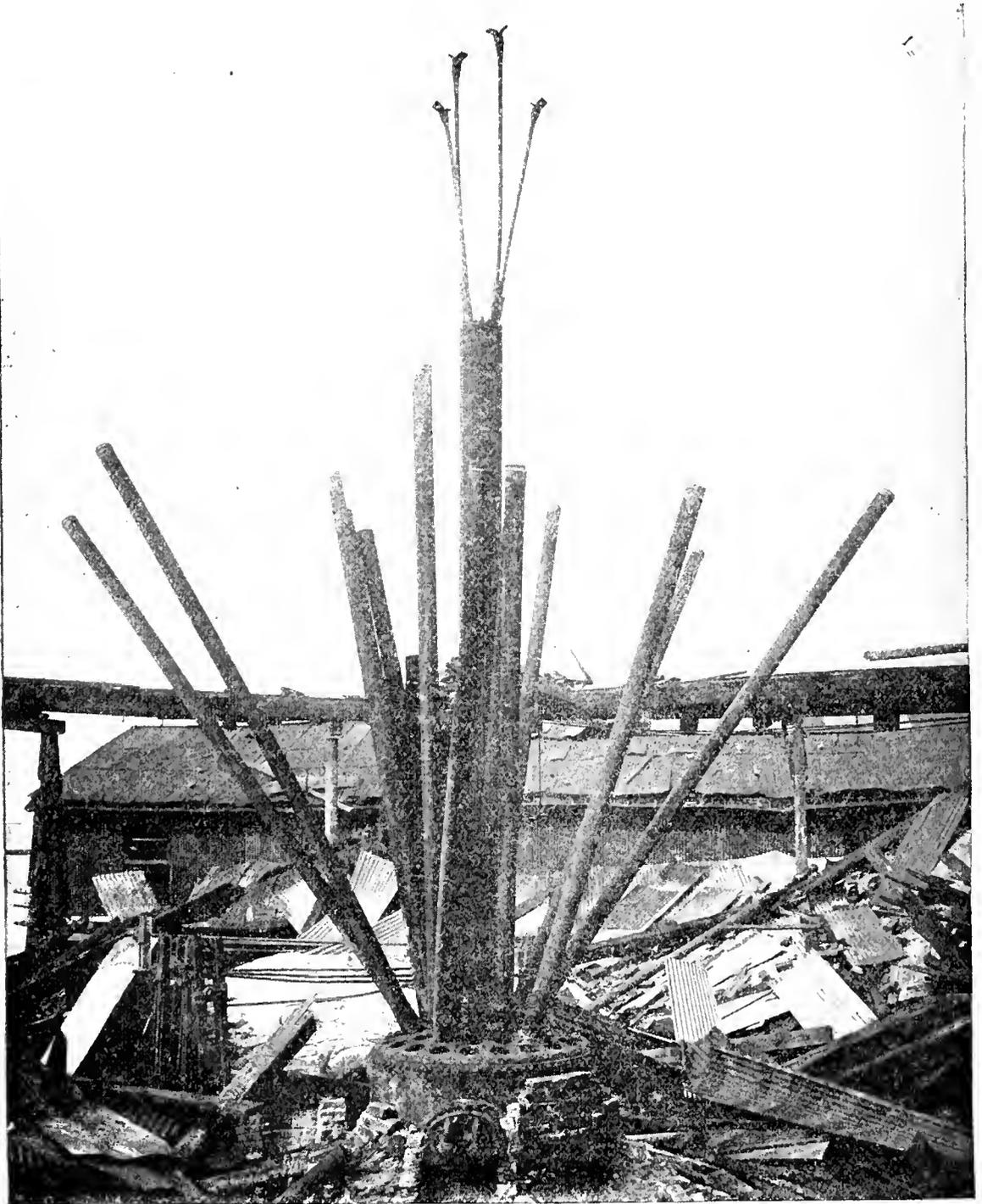
FIG. 2.—SHOWING THE EXPLODED BOILER IN DETAIL.
