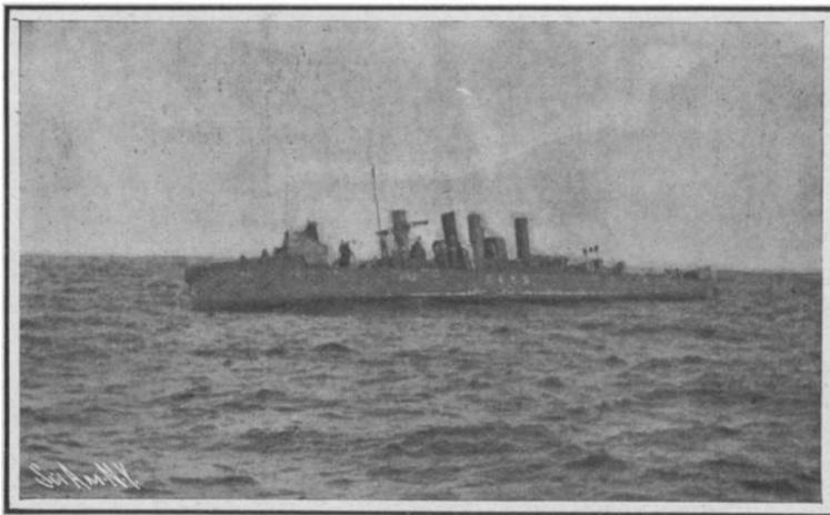
PHOTOGRAPH OF A JAPANESE TORPEDO BOAT, SHOWING DUMMY SMOKESTACKS.
