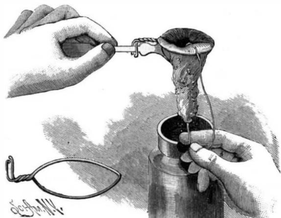
Fig. 2.—TRANSFERRING MATERIAL TO THE BOTTLE.
