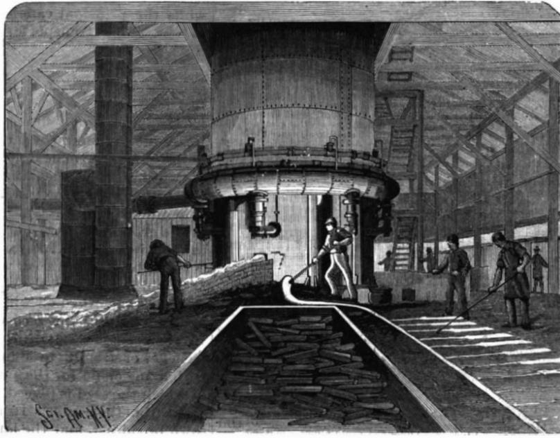
Fig. 4.—TALLAPOOSA BLAST FURNACE—MAKING A CAST.
