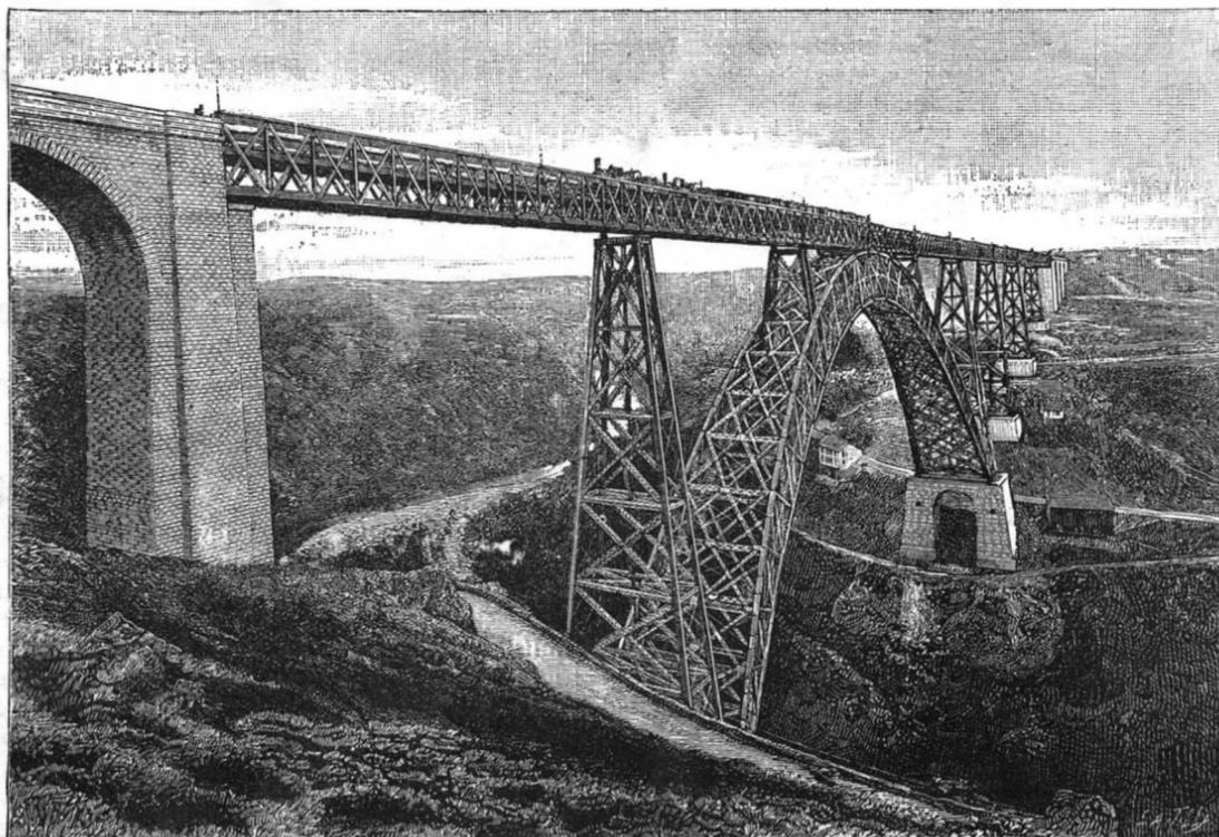
Fig. 3.—TESTING THE VIADUCT UNDER THE WEIGHT OF A 405 TON TRAIN.
