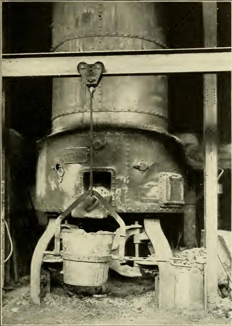
FIG 5. A TROLLEY LADLE IN POSITION AT THE CUPOLA.
