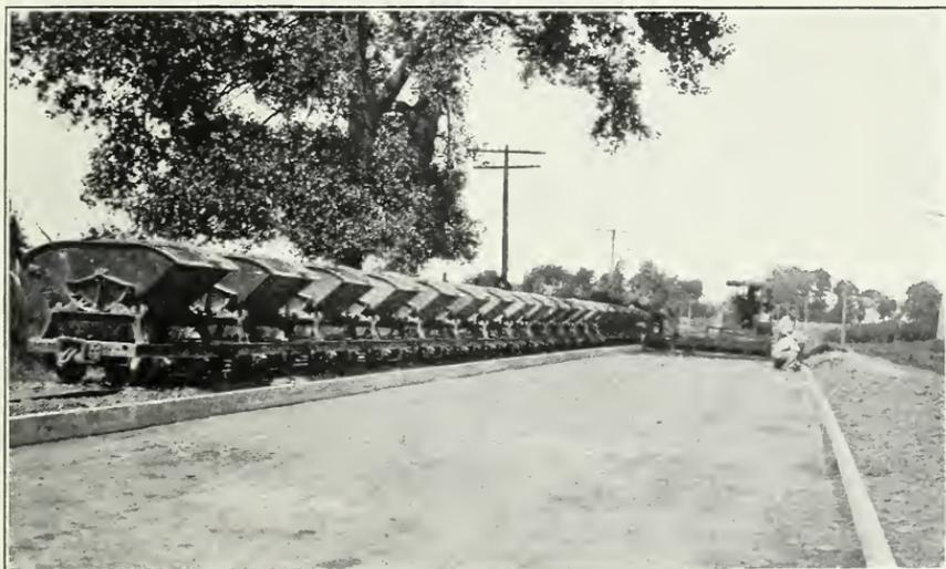
FIG. 2.—THE FINISHED SUBGRADE.
