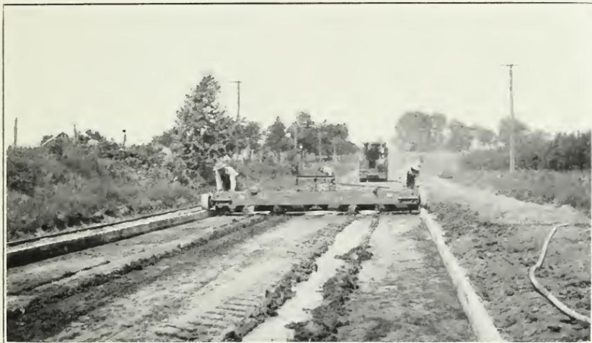
FIG. 1.—SUBGRADE PLANER IN OPERATION.
