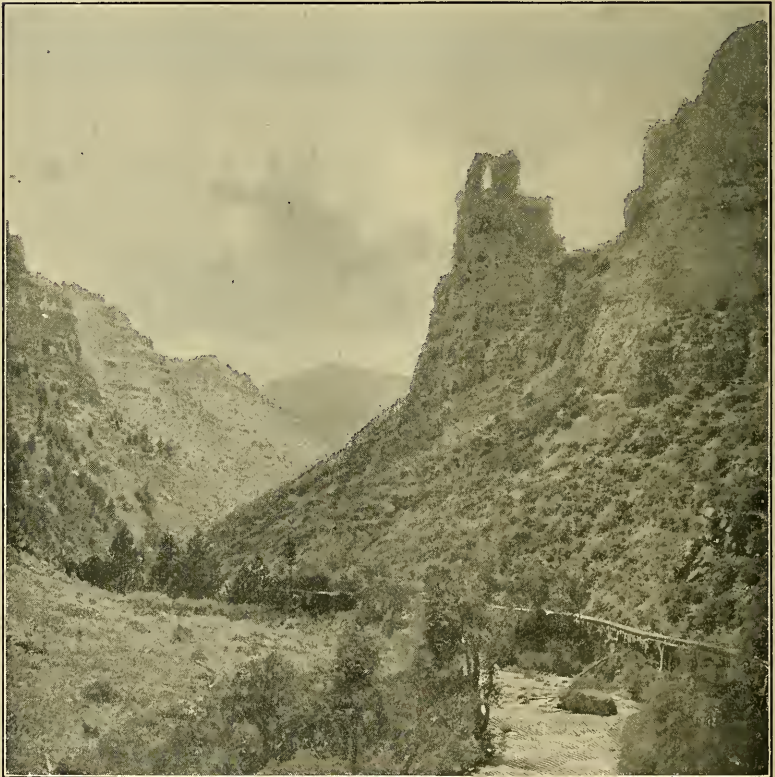
Fig. 60. — Talus slopes, Tongue River cañon, Wyoming. Note irrigation conduit. (U. S. G. S.)
