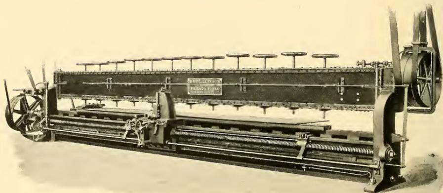
PLATE-PLANING MACHINE—WITH END-PLANING ATTACHMENT FOR
