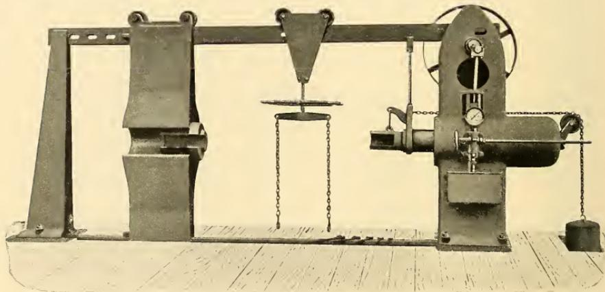
72" HYDROSTATIC WHEEL PRESS.—150 TONS CAPACITY.
