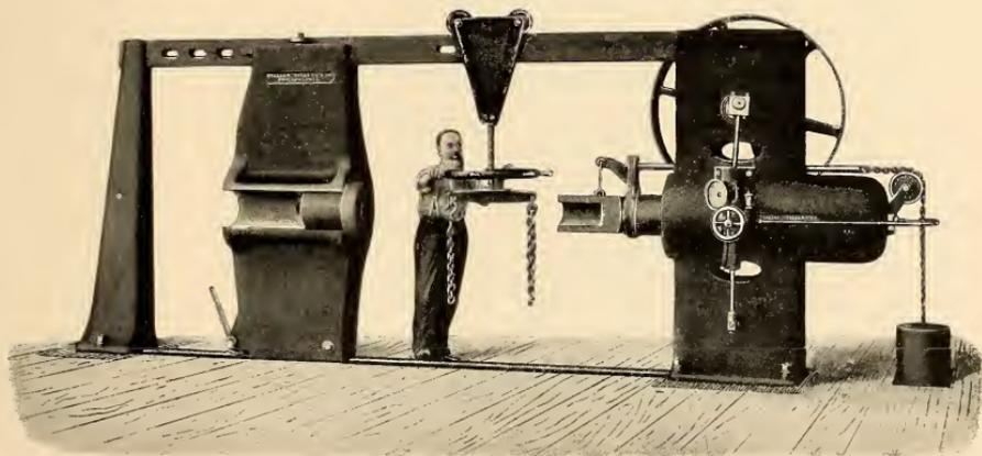
**84" HYDROSTATIC WHEEL-PRESS.—200 TONS PRESSURE.**
