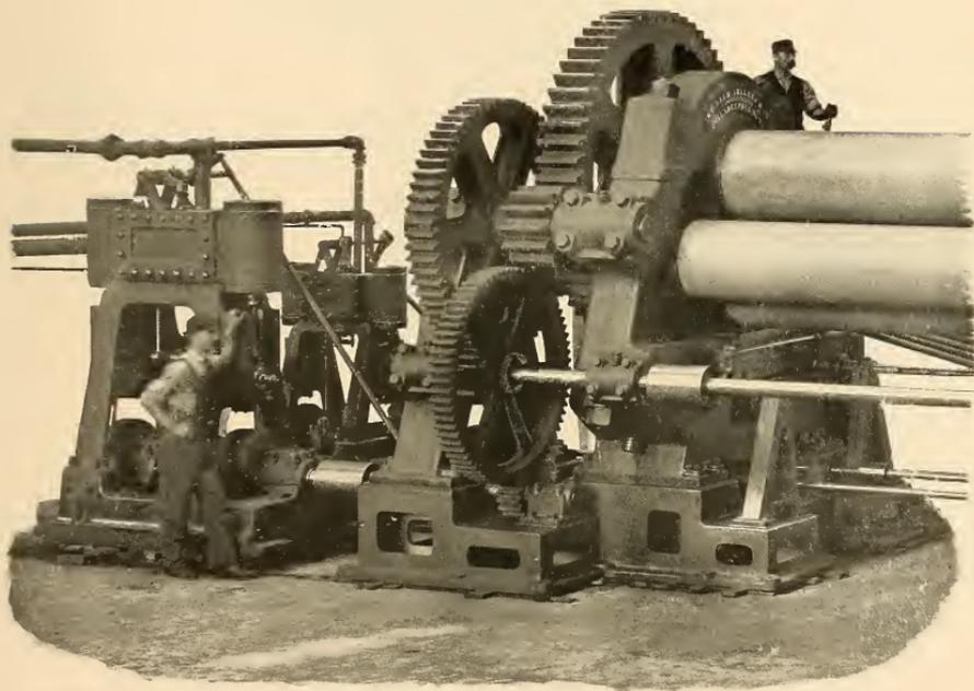
24" PLATE BENDING ROLLS.—22 FEET 6" BETWEEN HOUSINGS.
