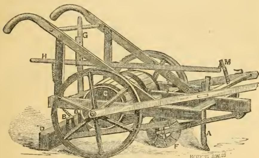
Fig. 5.—INGERSOLL'S REVOLVING COTTON-SEED PLANTER.
