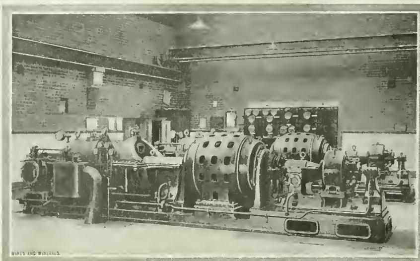
FIG. 1. STEAM TURBINE GENERATORS AT CLOCK FACE COLLIERY
