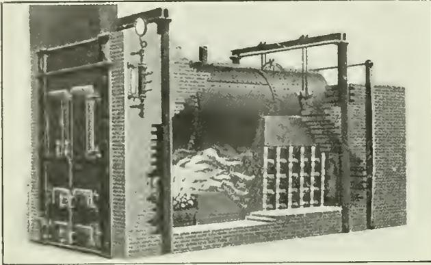
FIG. 1. FURNACE GAS CONSUMER ON RETURN TUBULAR BOILER
