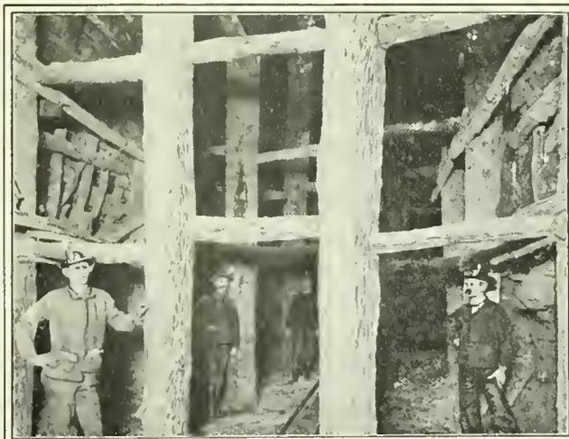
FIG. 3. TIMBERING IN SOFT GROUND ZINC MINE
