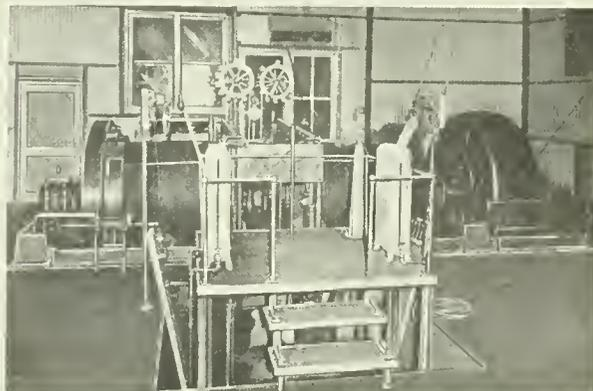
FIG. 2. ELECTRIC HOIST IRISH MAG MINE
