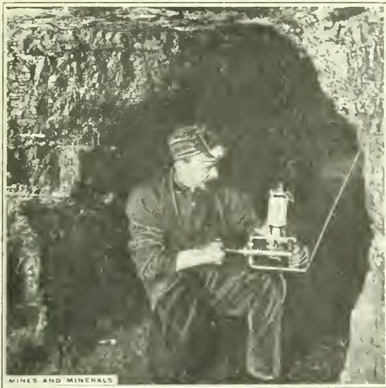
FIG. 1. TESTING FOR GAS
