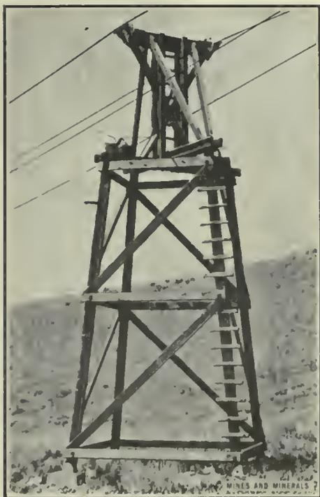
FIG. 1. TRAMWAY TOWER
