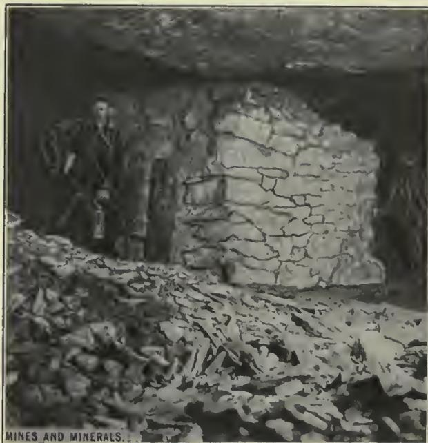
FIG. 2. MASONRY PILLAR
