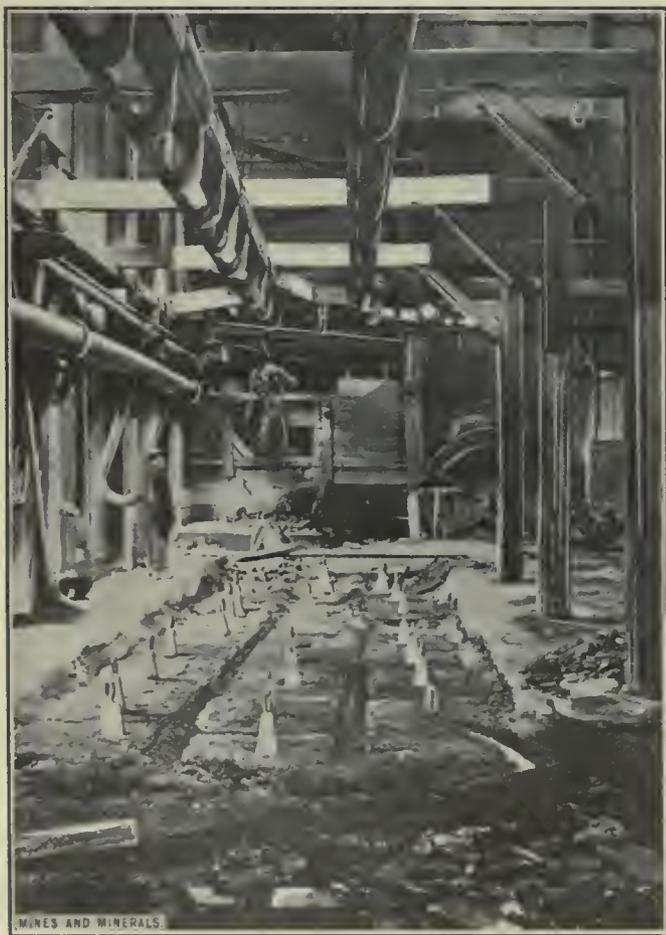
FIG. 3. MATTE MOLDS BEFORE CASTING
