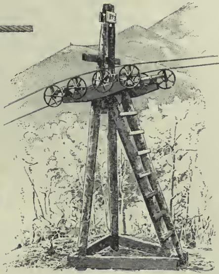
FIG. 50. TRAMWAY TOWER
