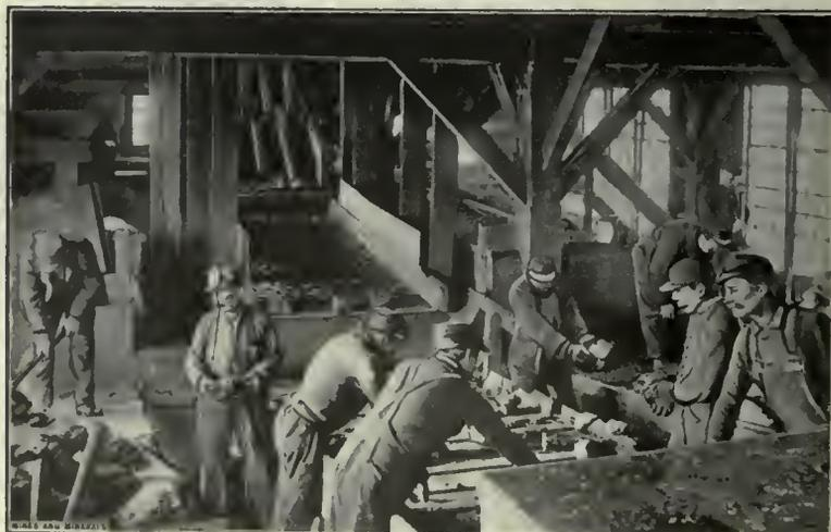
FIG. 3. LUMP-COAL SHAKERS AND PICKING TABLE
