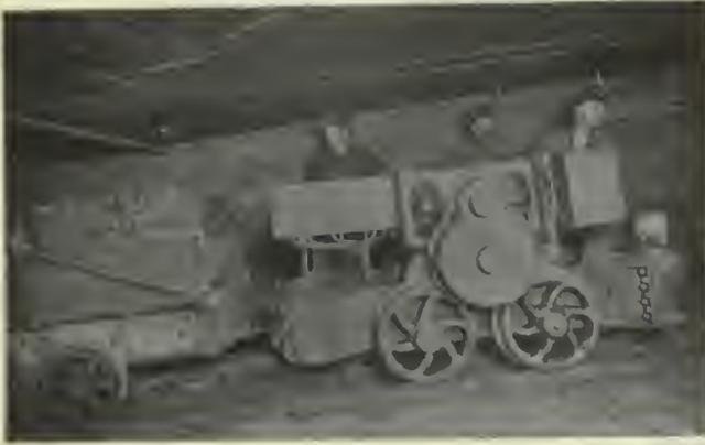
FIG. 64. PLAIN RACK LOCOMOTIVE ON 16-PER-CENT. GAUGE
