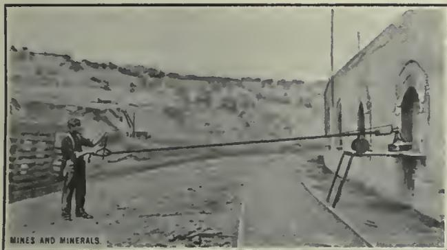
FIG. 1. TILE-LAYING MACHINE
