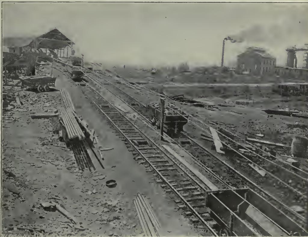
FIG. 38. ENDLESS-ROPE HAULAGE
