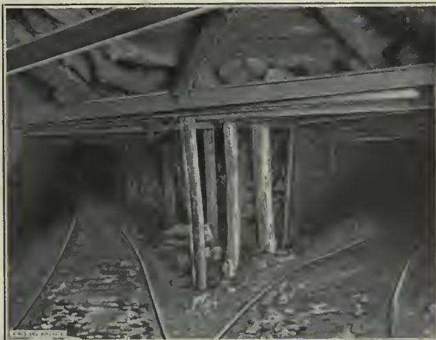
FIG. 2. STEEL MINE TIMBERS, FLORENCE MINE, Y. & O. COAL CO., MARTIN'S FERRY, O.
