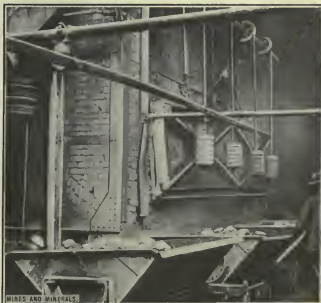
FIG. 4. FURNACE CHARGING DOORS
