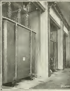
FIG. 11. 6000-KV.-A. TRANSFORMERS
