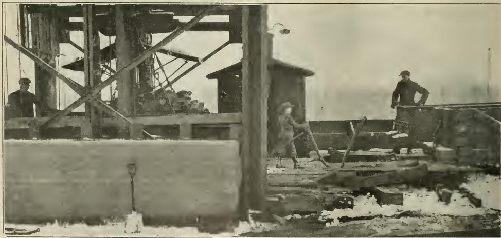
WATKINS CAR STOPS ON THE EMPTY TRACK SIDE OF SHAFT
