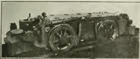
FIG. 5. INSIDE-FRAME TWO-MOTOR TROLLEY LOCOMOTIVE
