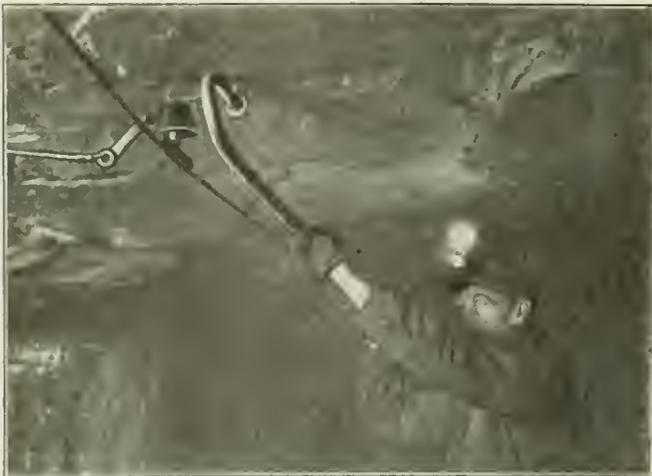
FIG. 14. PULLING TOOL IN USE
