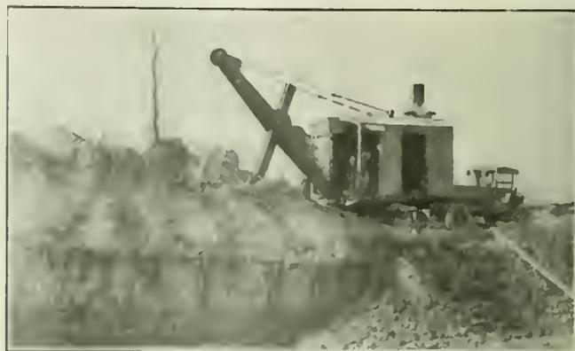
FIG. 5. STRIPPING OVERBURDEN FROM THE COAL
