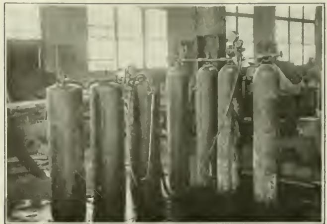
**FIG. 8. CYLINDERS CONNECTED BY MANIFOLDS**
