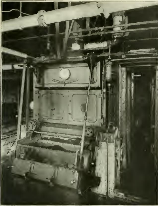
FIG. 1. TEST BOILER AND ANTI-CAKING STOKER
