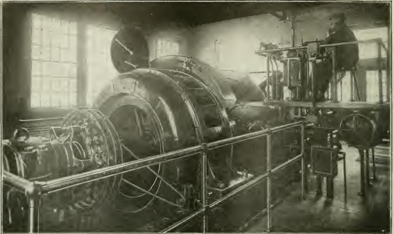
FIG. 5. MOTOR END OF HOIST, SHOWING OPERATOR'S PLATFORM AND POSITION-INDICATING DIAL
