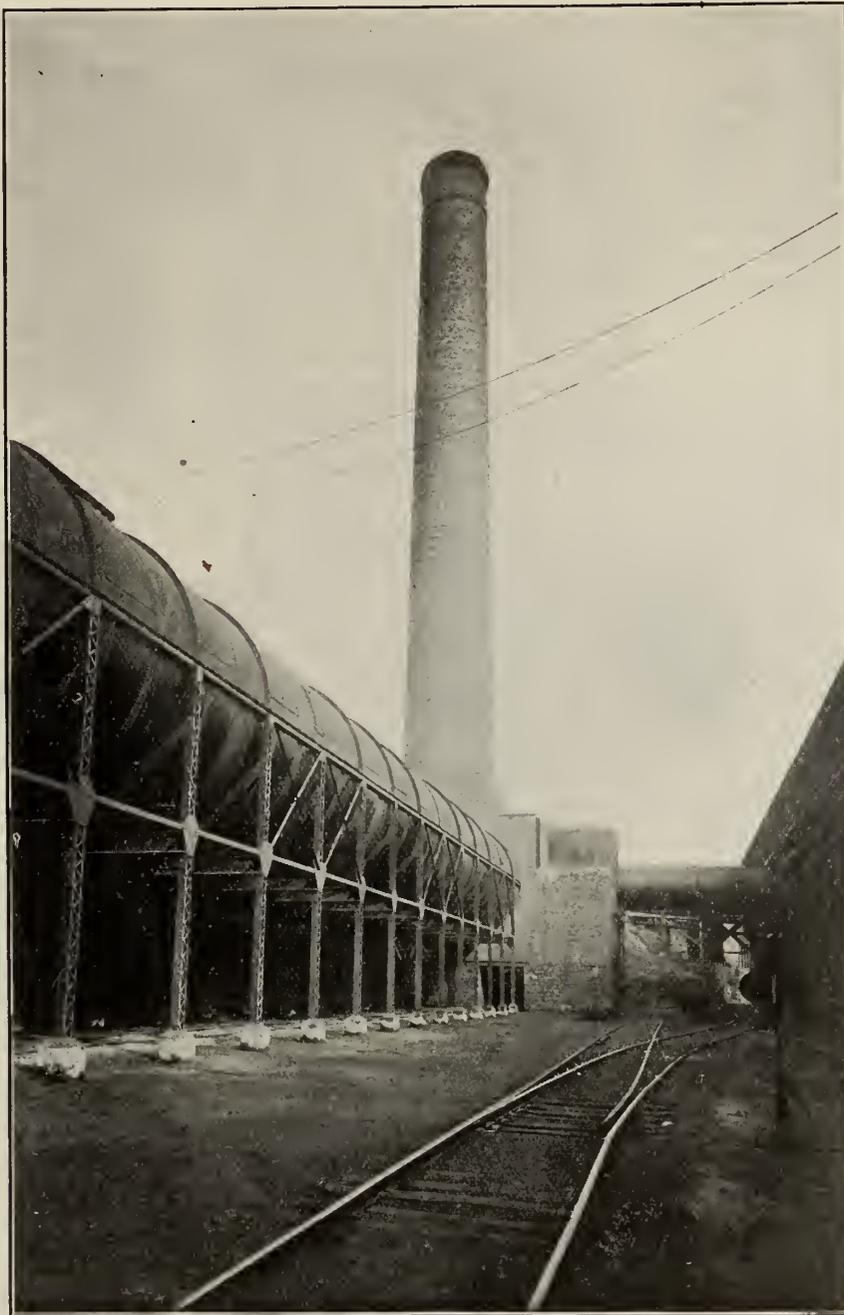
BLAST FURNACE FLUE, CANADIAN COPPER CO., COPPER CLIFF, ONT.
