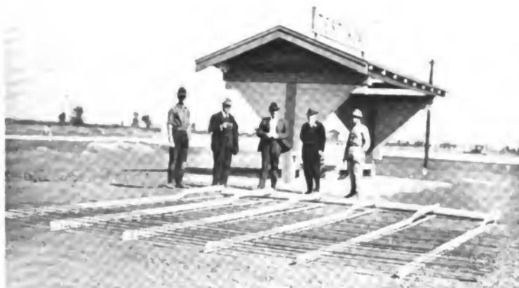
SPECIAL DEVICE FOR PLACING REINFORCING STEEL
