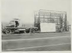
WALL PANELS BEING TRANSPORTED IN SPECIAL TRUCKS DOWN BAYSHORE HIGHWAY
