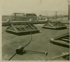
COMPLETION OF MASTIC INSTALLATION. A THREE HUNDRED POUND ROLLER USED TO CONSOLIDATE THE MASTIC
