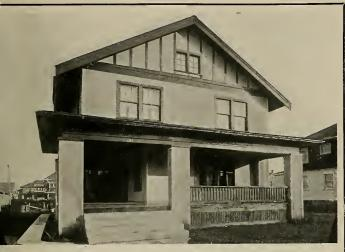
THE BRAIN RESIDENCE AT SPRINGFIELD. OHIO. ARMCO IRON SPIRAL LATH EMPLOYED AS BASE FOR STUCCO
