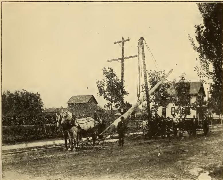
FIG. 559.—DERRICK WAGON—POLE PARTLY RAISED.
