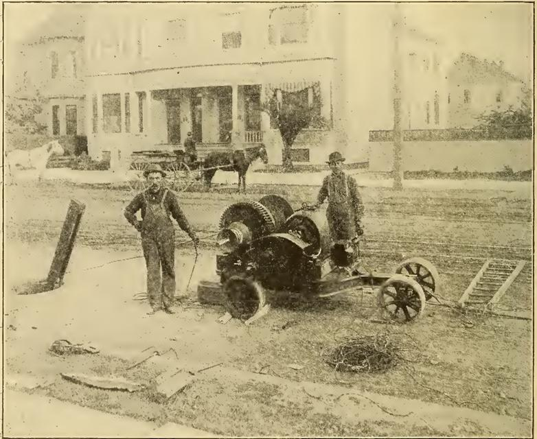
FIG. 621.—ELECTRIC WINCH.
